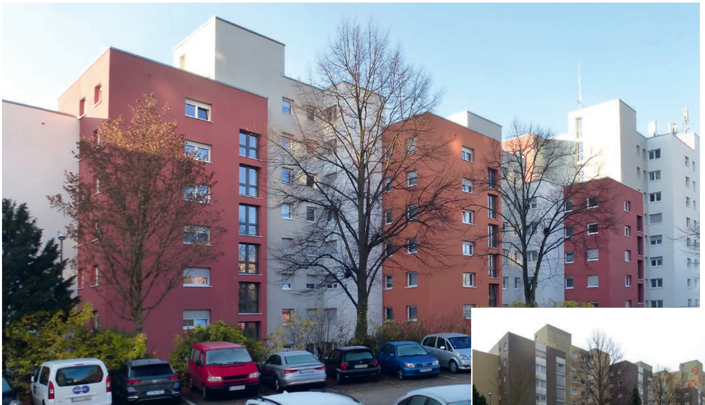
Vorher-Nachher-Betrachtung des Rohrdommelwegs 2 bis 12
